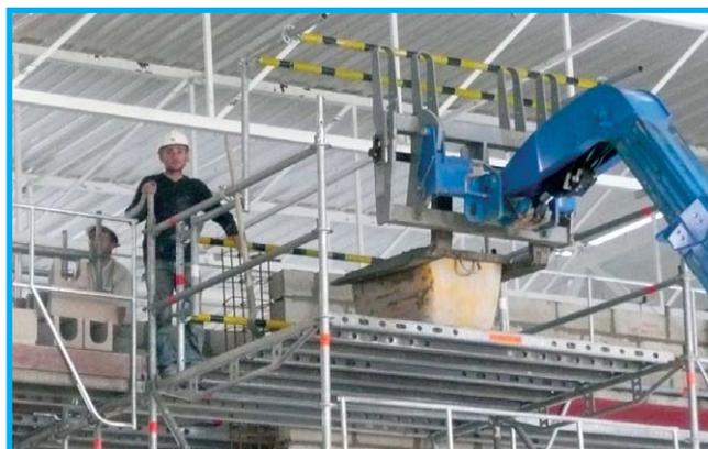
Existe en largeur de 2,57 m pour des recettes de 2,07 m à 3,07 m de profondeur
