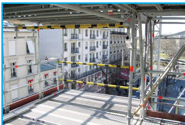
1. En position fermé, le garde-corps en rive d'échafaudage protège les utilisateurs des risques de chute.
