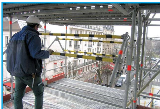
2. En basculant pour permettre l'approvisionnement de la recette, l'opérateur se retrouve protégé par un nouveau garde-corps l'isolant de la zone à risque.
