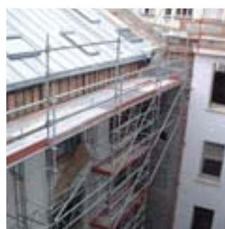
Protections pour travaux de couverture
