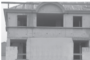
Exemple façade ouverte avec 30 % d'ouverture
