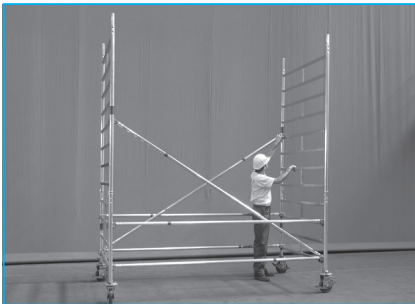
2 - Pose des cadres 8 barreaux puis les diagonales.
