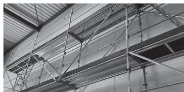
Exemple de franchissement en Uni-Safe en utilisant un montant porte-à-faux Uni-Safe 1,16 m
