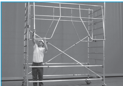
3 - Pose des garde-corps de sécurité définitifs.
