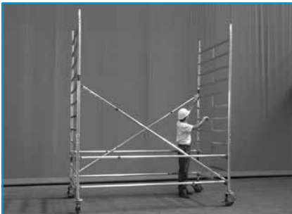
2 - Pose des cadres 8 barreaux puis les diagonales.
