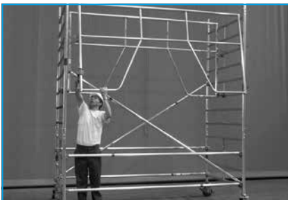
3 - Pose des garde-corps de sécurité définitifs.
