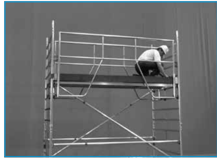
4 - Pose du plancher à trappe, accès au niveau supérieur et pose des plinthes.
