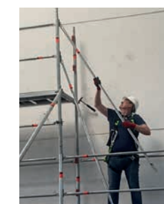
Insérer les 2 lisses dans les clips fermés.
