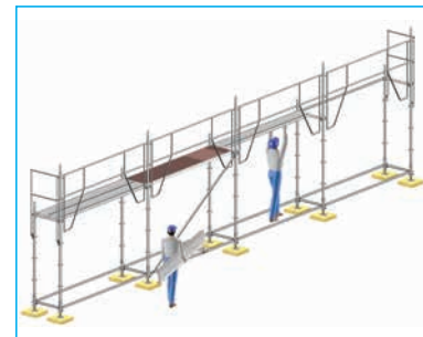
(3) Mise en place des planchers du 1 er étage.
