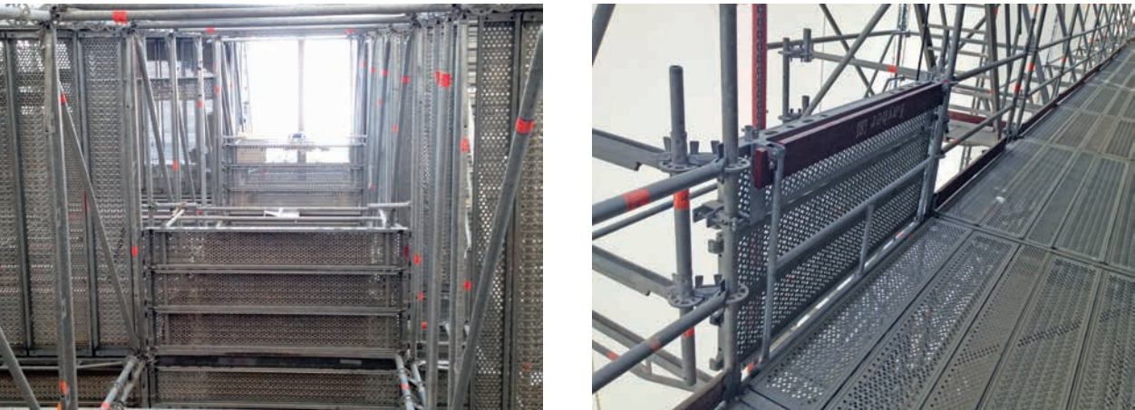
En position horizontale, le plancher peut recevoir la charge apportée par le treuil du monorail
