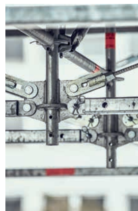
Assemblage rapide par axes et goupilles
