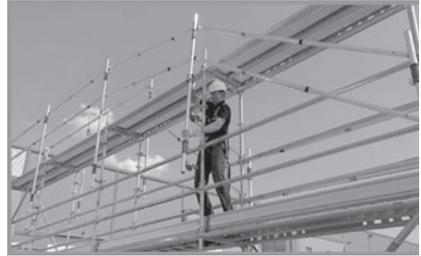
Deux types d'élément : le montant à poignée de déverrouillage et la lisse aluminium extensible en deux dimensions. La poignée de déverrouillage, actionnée en partie basse ou haute du montant, permet de desserrer les deux mâchoires et de monter ou descendre la protection d'un niveau, les lisses étant emboîtées sur les ergots à bascule du montant.
