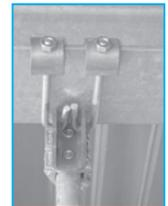
Des colliers spéciaux de suspension permettent aussi de reprendre les montants verticaux et ce pour des charges plus importantes ( $F_{\max} = 1500$  daN). Ils sont équipés de 2 crochets de sécurité pour assurer la tenue horizontale et l'anti-déversement.
